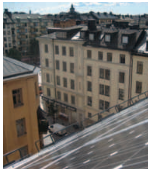
Fastighetsbolaget Svenska Bostäder har byggt ett solcellssystem på en av deras lokala kontor i Stockholm. Foto: Direct Energy AB
