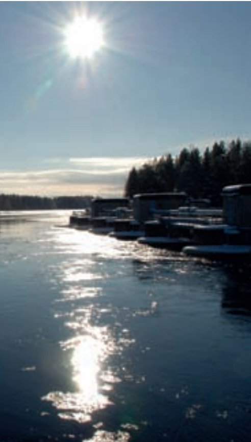
Älvkarleby kraftstation. Foto: Cristian Andersson
